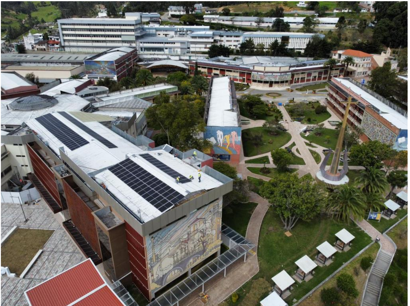
Ubicación de paneles solares en Edificio 7 del campus UTPL
