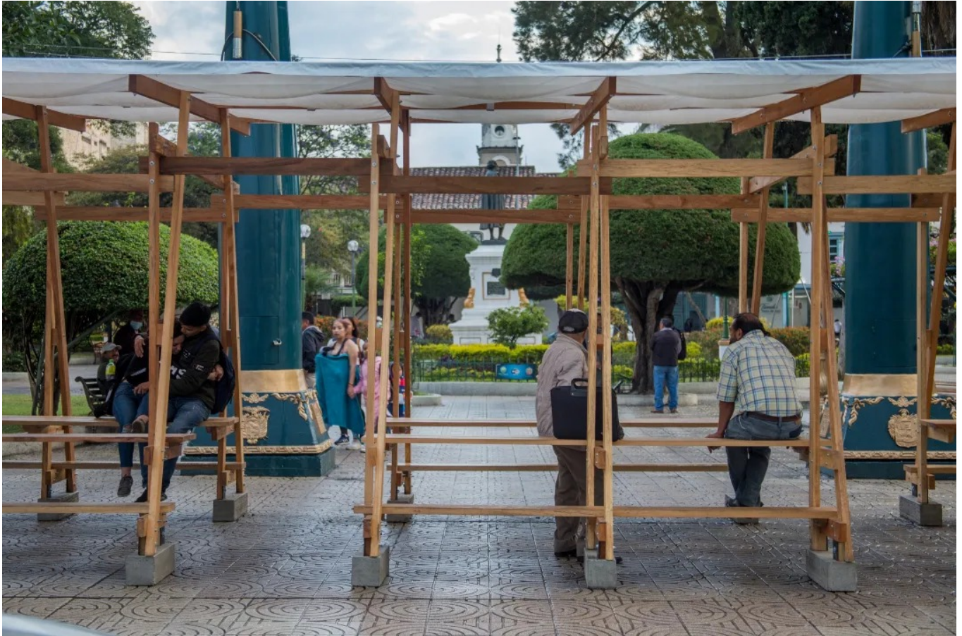
Pabellón desmontable de madera en el parque Central de Loja. Foto: Freddy Bonilla
